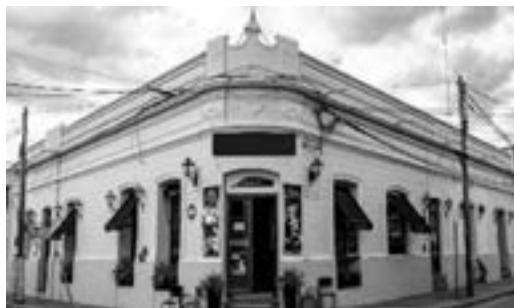
En este edificio funcionó la Sucursal Cafayate del Banco de la Nación Argentina en 1896. Actualmente, esquina de Avda. Gral. Güemes (S) y Belgrano, en diagonal a la plaza 20 De Febrero.
