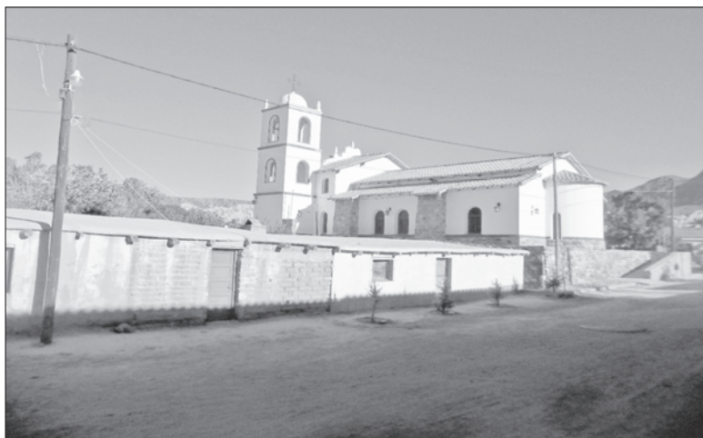
Vista de la Iglesia de Angastaco desde atrás.
